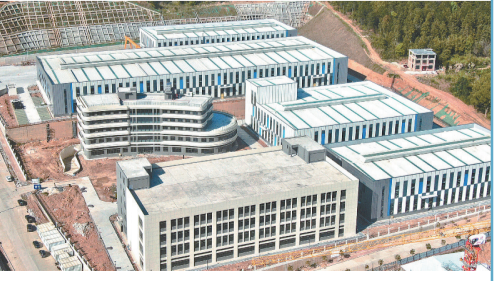
【綠洋項目建設現場】
